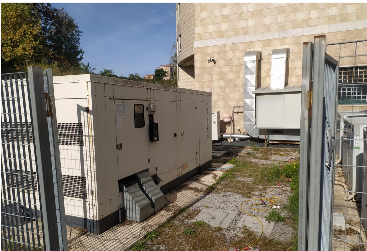
Figura 2 – Struttura oggetto delle indagini
